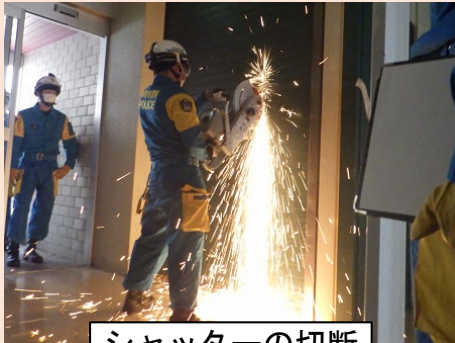
シャッターの切断
