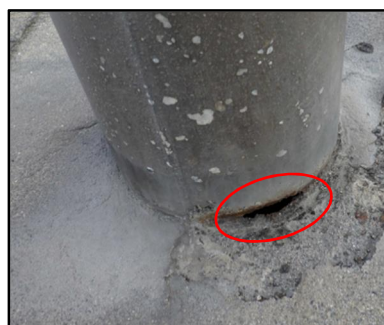
【腐食し穴のあいた信号柱】
